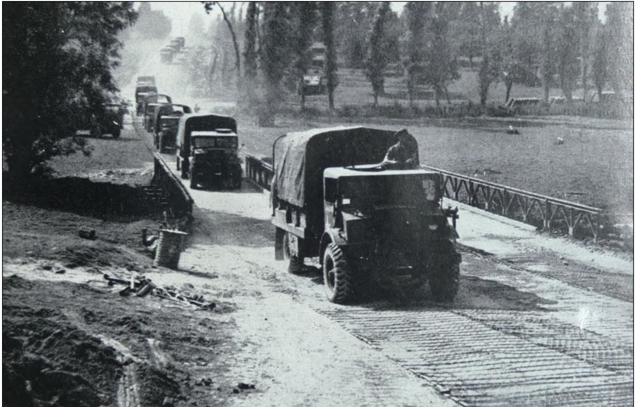
Britse legertrucks rijden over Sommerfeld trackings in Bayeux, Frankrijk, 1944. (Foto: Rickard, J (29 May 2021), Trucks using Sommerfeld Track, Bayeux, historyofwar.org/Pictures/pictures_sommerfeld_track_bayeux.html )
